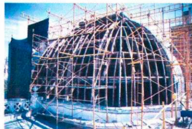
Cúpula Sur con su andamiaje.
