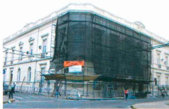
Trabajos de recuperación sobre la calle Guardia Nacional.
