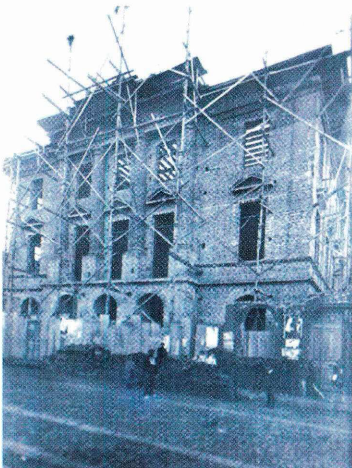
Palacio en construcción.
