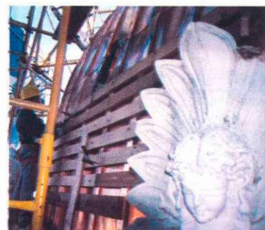
Recolocación de pizarras recuperadas y/o nuevas.
