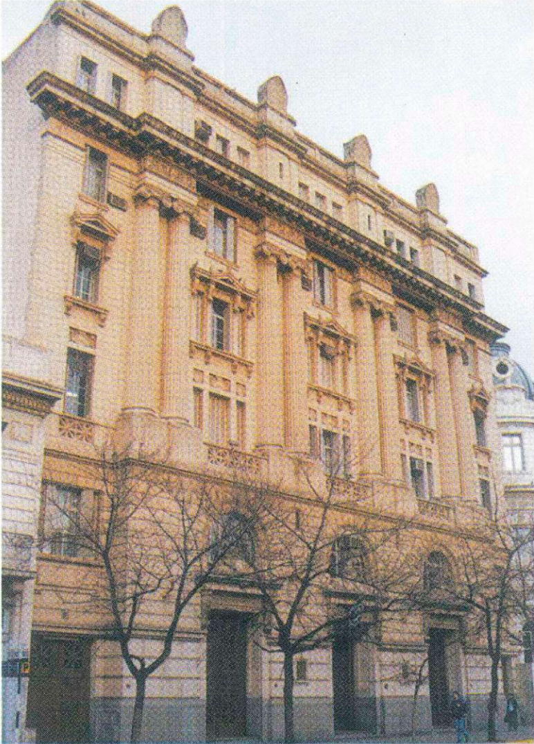
Fachada. Detalles de ornamentación.
