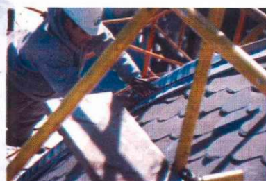
Operario soldando los cordones de terminación en cinc puro.
