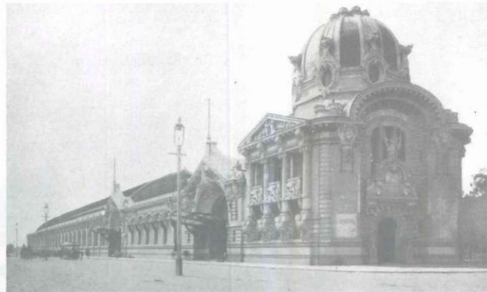
Estación de Tren.
