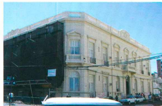
Trabajos de recuperación sobre la calle Mitre.
