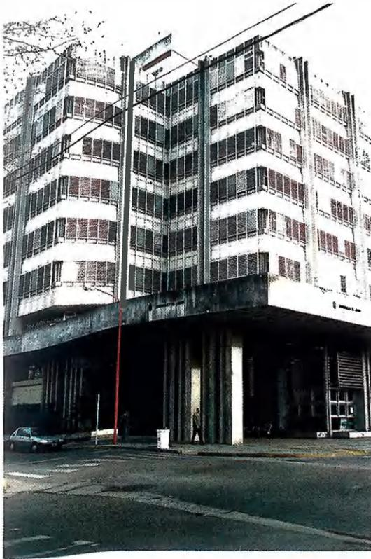
Fachada del edificio, donde se observa el techo en voladizo del acceso.
